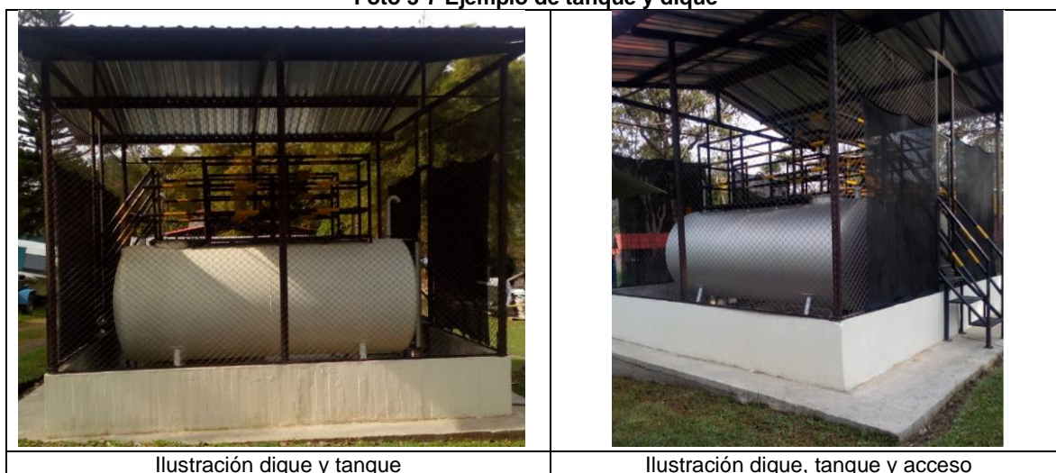
Foto 3-7 Ejemplo de tanque y dique
