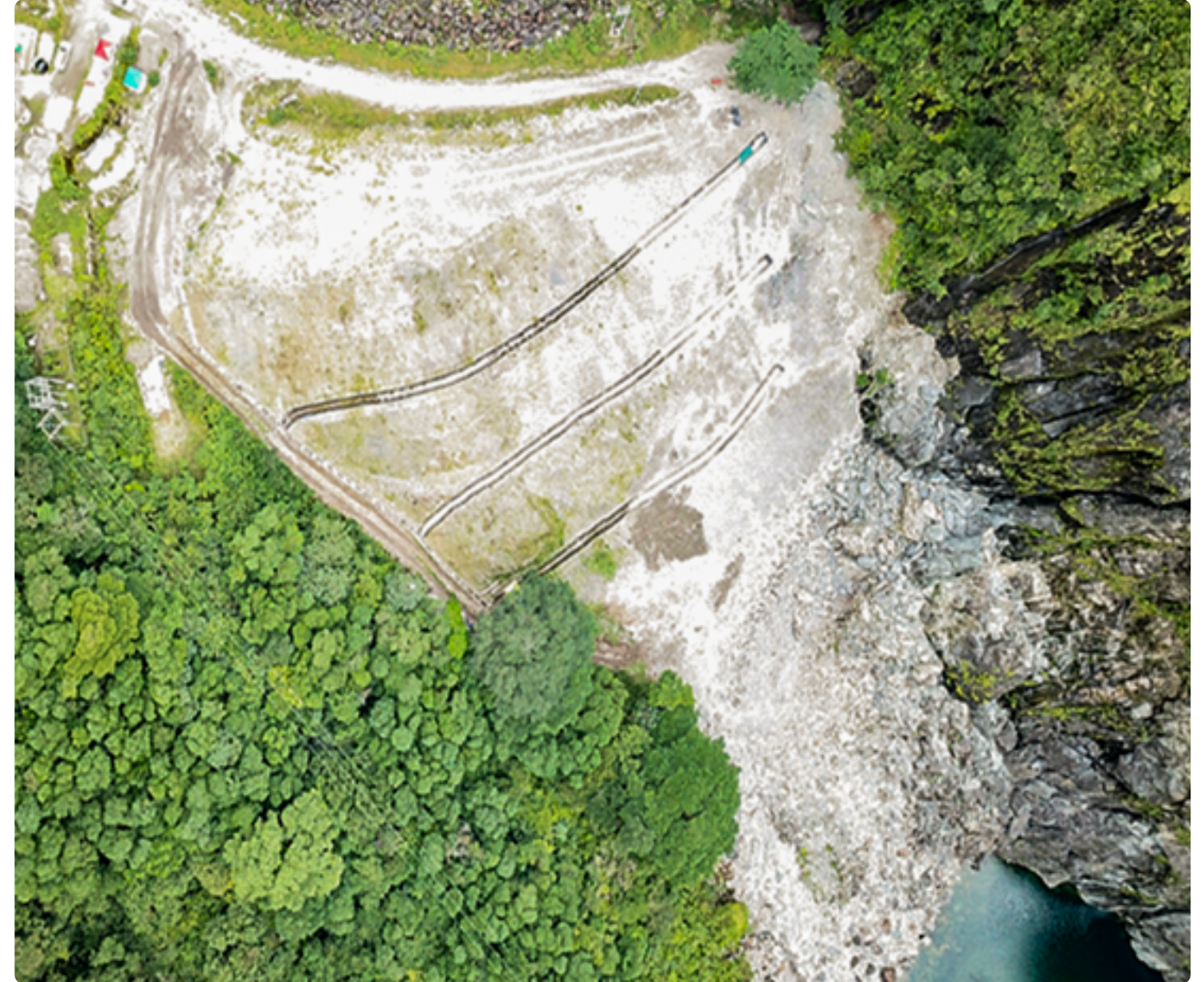
Panorámica de la ZODME finalizada
