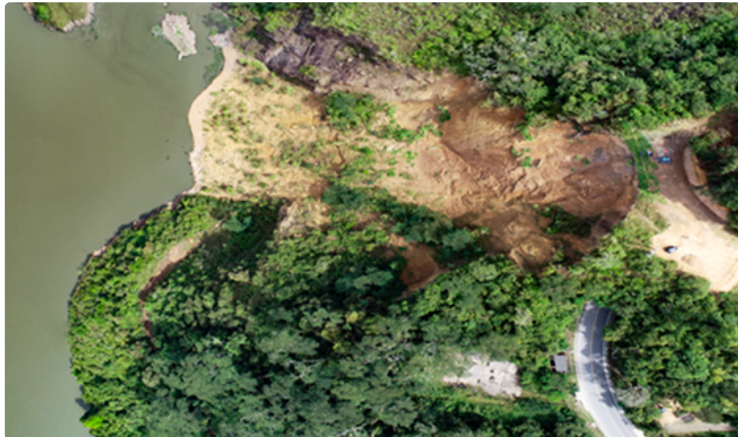
Panorámica del talud por intervenir
